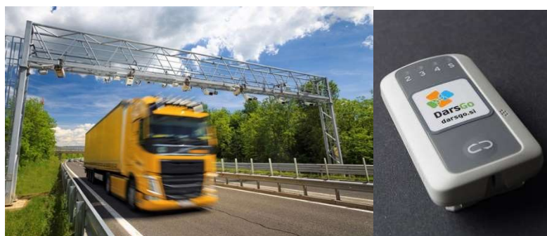
図 2-39 フリーフローETC のガントリーと DarsGo 車載器(5.8GHz)
