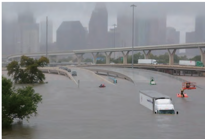
図 3-11 ハリケーン「ハービー」の影響でテキサス州ヒューストンに広範囲にわたる洪水が発生した時に水没した I-45 の区間（2017 年 8 月 27 日）。
