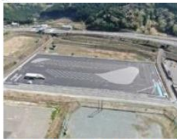
浜松いなさ路外駐車場
