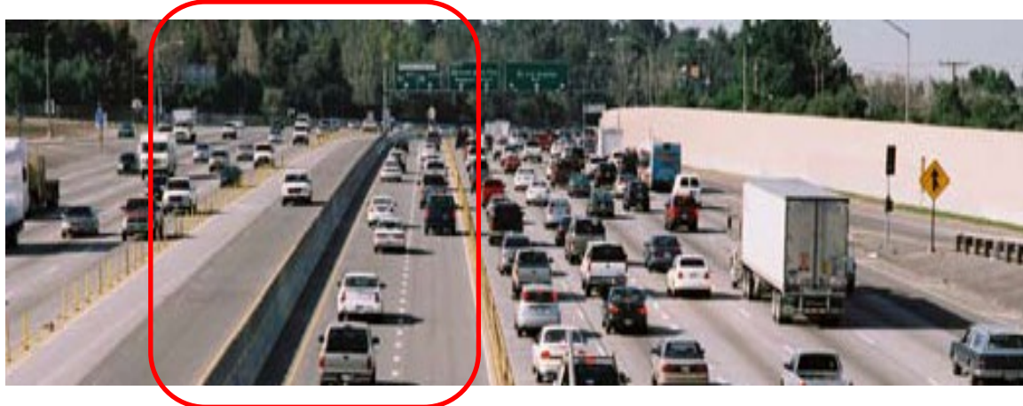
カリフォルニア州の州道91号のHOT車線と一般車線
