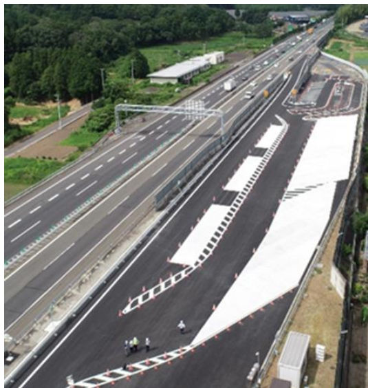
鈴鹿臨時駐車場：本線料金所跡地
