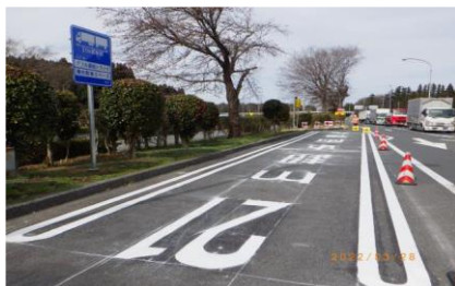
ダブル連結トラック駐車マスの整備状況 (東北道 黒磯PA(上り))
