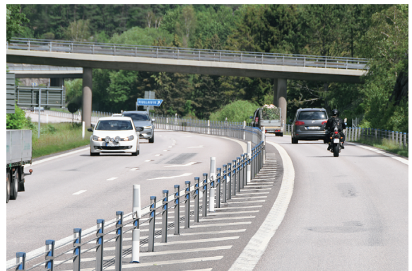
写真六 2+1（ツープラスワン）道路状況 (国道158号 ヨーテポリ近郊 Kullavik 付近)
