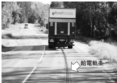
写真一4 一般道に設置された走行中給電設備（現在は実験を終了し、残置されている）
