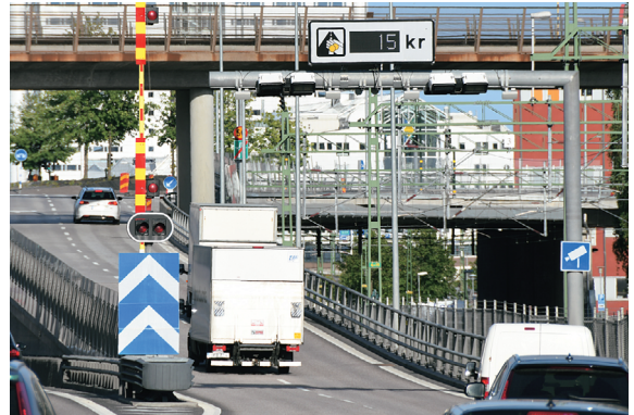
写真二 道路混雑課金徴収設備 (E20号 スtockホルム Hjorthagen 付近)
