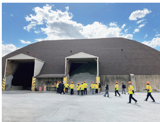
凍結防止剤保管状況
