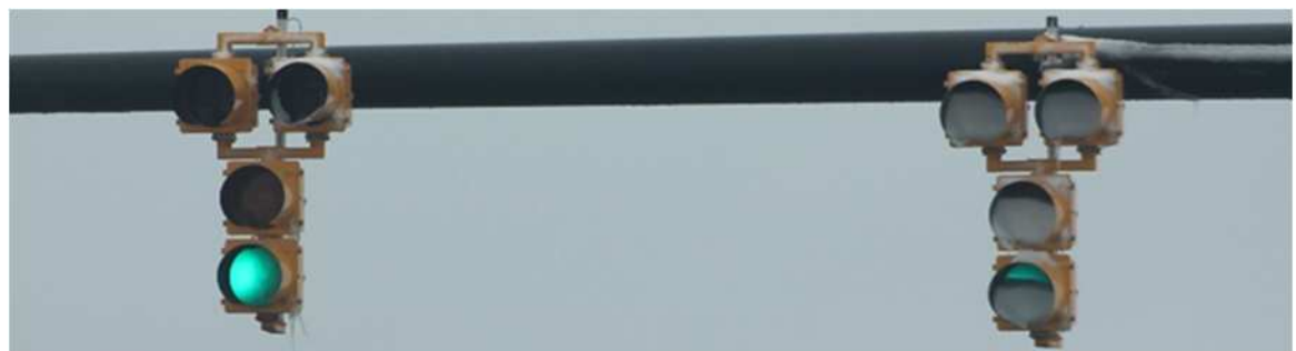
写真 2-3-19 ヒートテープによる融雪効果 (左：ヒートテープ有、右：ヒートテープ無)
