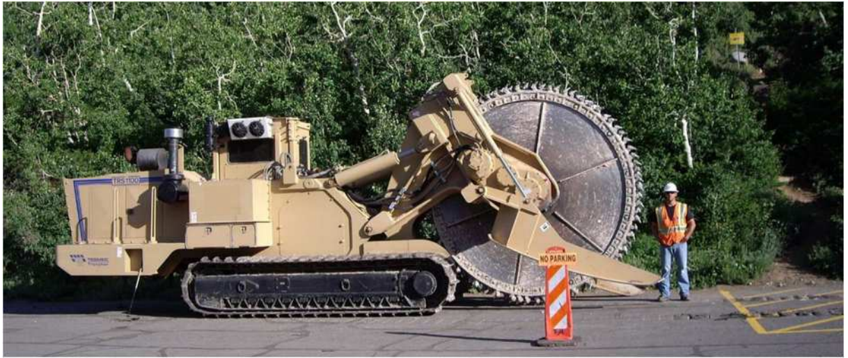
写真 2-3-8 円盤状のブレードを装備した掘削専用機械
