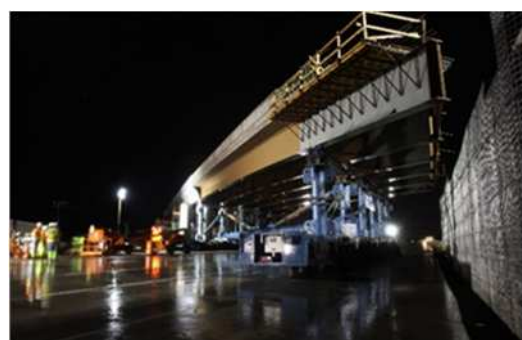
写真 2-2-1 多軸式台車一括架設事例 (左：昼間作業、右：夜間作業)
