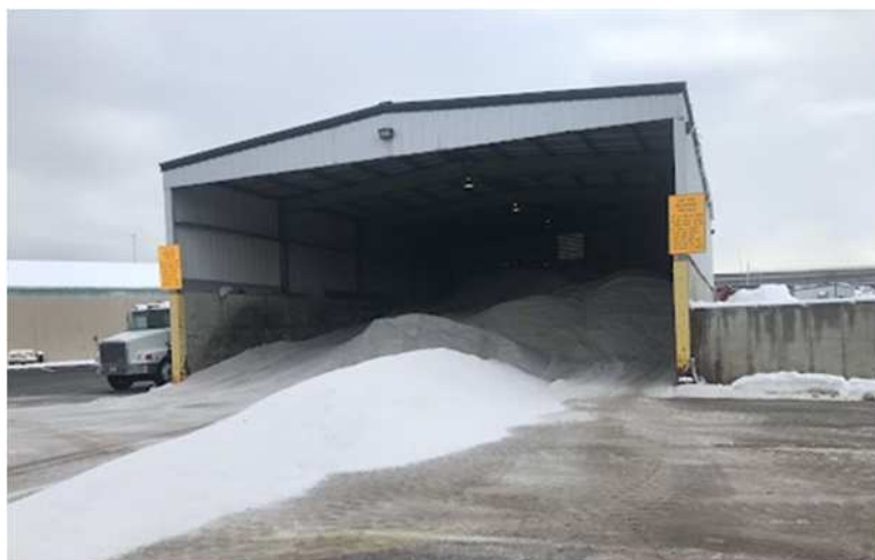
写真 2-2-28 凍結防止剤の貯蔵倉庫
