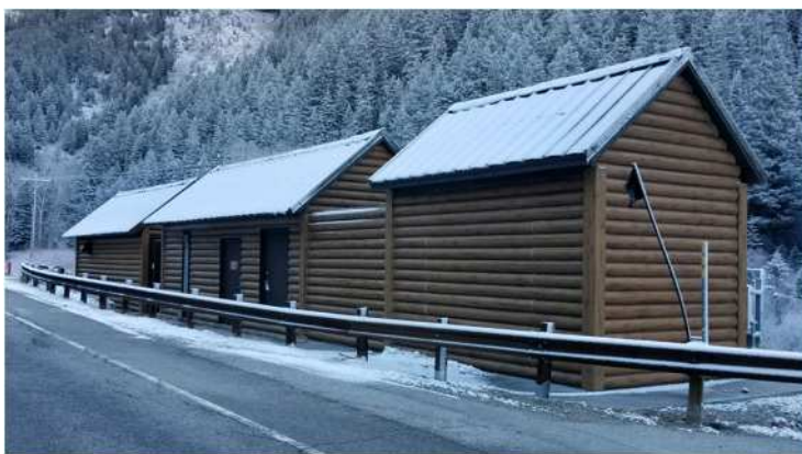
写真 2-3-12 景観を考慮した中継装置用建屋
