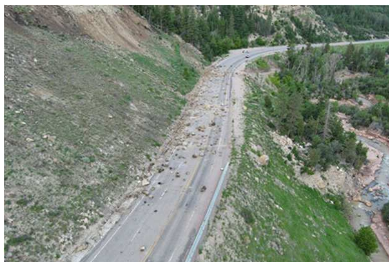
写真 2-2-22 落石発生状況
