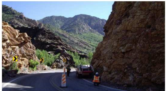
写真 2-3-10 落石に注意が必要な急カーブでの施工状況
