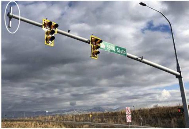
図 2-3-31 信号機の振動緩和対策
