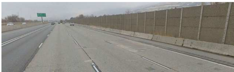
写真 2-3-22 車線と路肩状況
