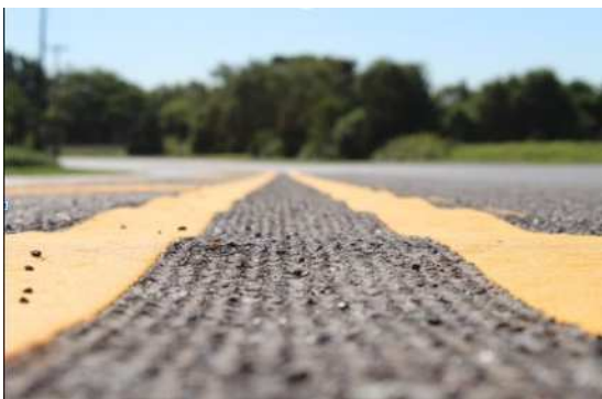
写真 2-2-9 正弦曲線ランブルストリップ
