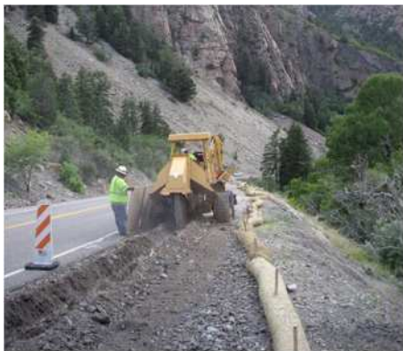
写真 2-3-9 施工時の防護状況
