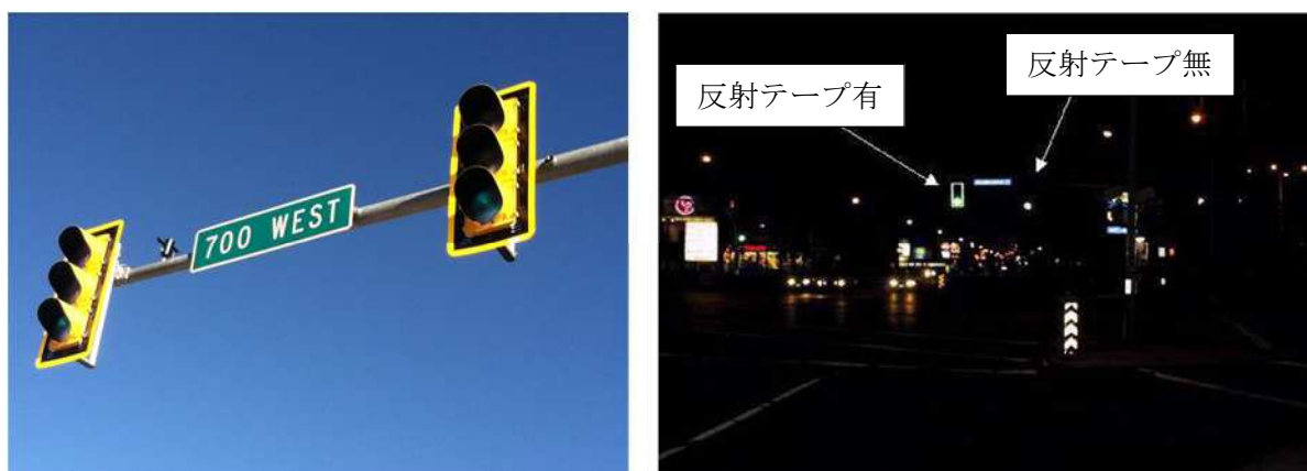
図 2-3-37 反射テープによる衝突事故軽減 (左：対策状況、右：実際の夜間視認状況)
