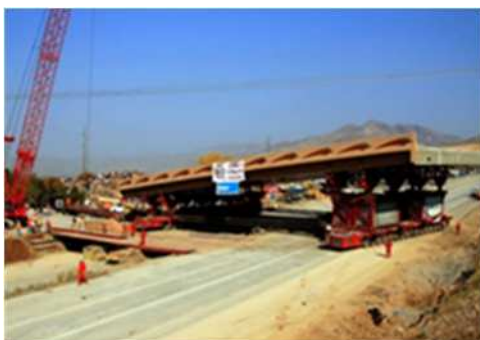
写真 2-2-1 多軸式台車一括架設事例 (左：昼間作業、右：夜間作業)
