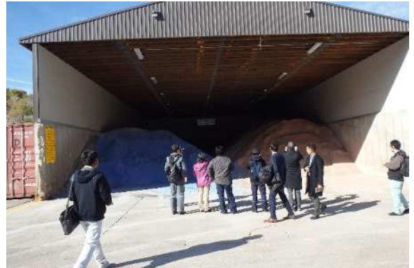
写真 5-22 凍結防止剤（塩）格納状況
