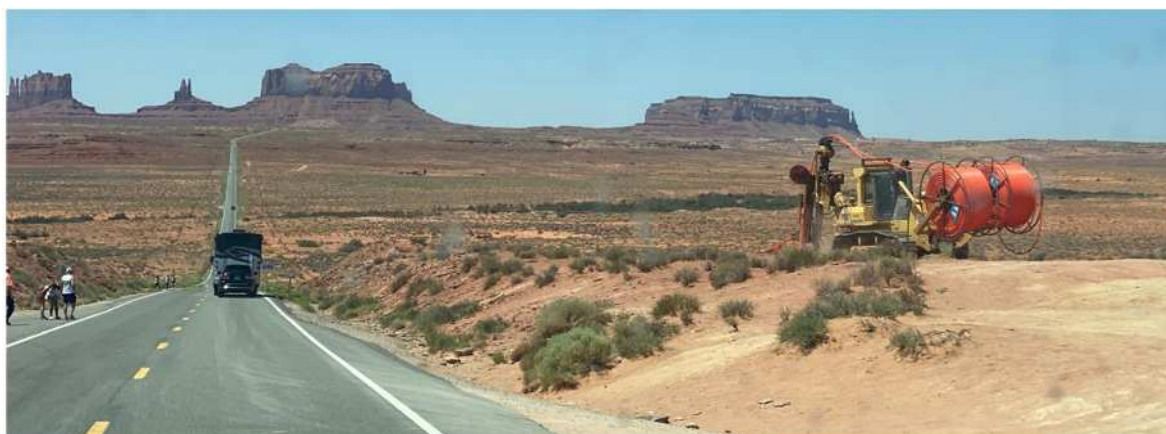
写真 2-3-6 フォレスト・ガンプの丘での施工状況
