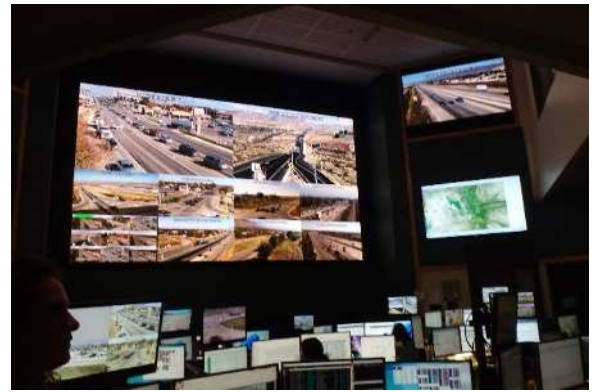
写真 5-13 ユタ州交通管理センター
