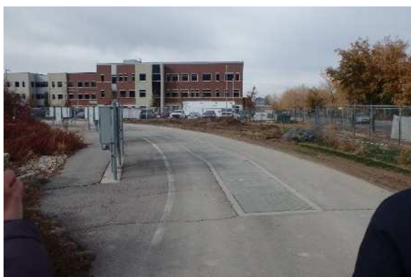
写真 5-28 自動給電 テストコース
