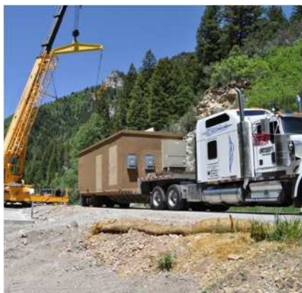
写真 2-3-11 プレハブ設置状況
