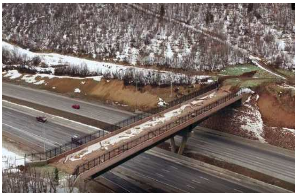
写真 2-2-31 野生動物専用の跨道橋
