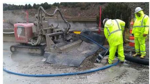
写真 2-2-4 ウォータージェット施工状況
