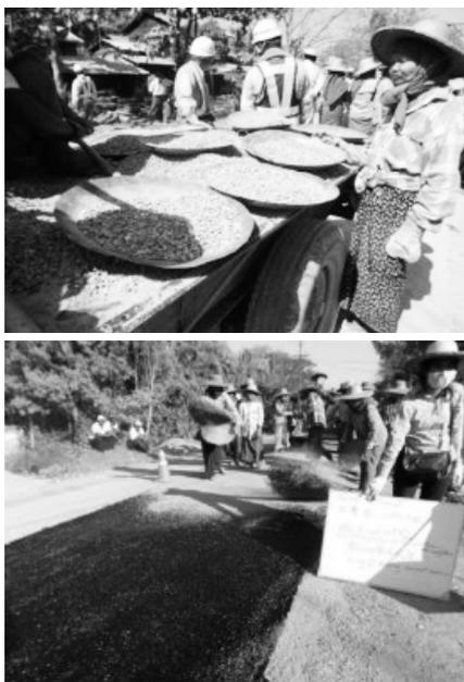
写真-1 住民参加による骨材の準備(上)と人力散布(下)
