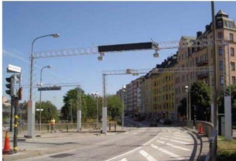
図 1-9 ストックホルムのガントリーに設置された電子的タグ・リーダーとカメラ
