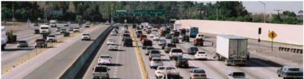
図 1-4 SR91 の有料レーンと無料レーン(プラスチックパイロンによる分離)
