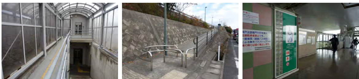
図2.2.13 (左) 神戸淡路鳴門道 鳴門北 BS（上り線）に設置されたエレベーター (中) 高松自動車道 三木 BS（下り線）のスロープ (右) 神戸淡路鳴門道 舞子 BS の多機能トイレ
