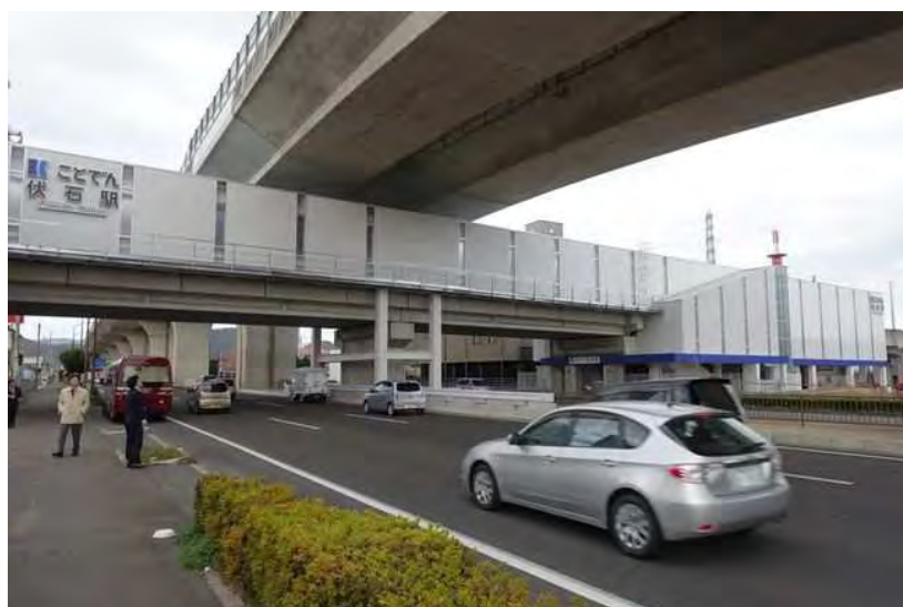
図3.1.6 (参考事例) 一般国道 11 号沿いに新設される伏石駅 (R1.12EHRF 撮影)
