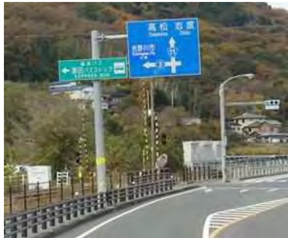
図3.1.8 (参考事例) 国道に設置された BS の案内看板 (R1.12EHRF 撮影)
