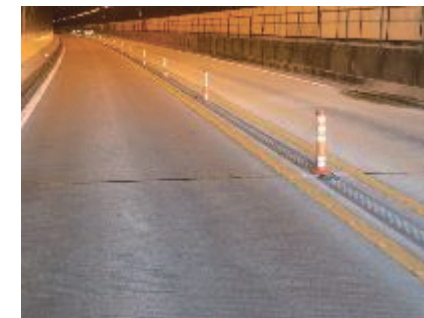
本四高速 宮窪トンネル
