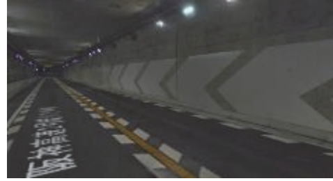
阪神高速 2号淀川左岸線(下り)
