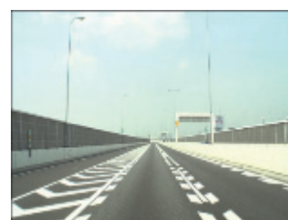
首都高速 埼玉大宮線(下り) 浦和北付近
