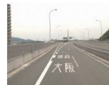
本四高速 神戸淡路鳴門道(下) 壺水JCT
