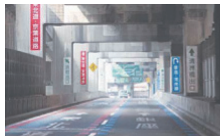
首都高 6号向島線箱崎JCT
