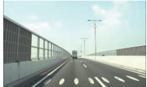
首都高速 埼玉大宮線(下り)浦和北付近
