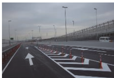
阪神高速 三号神戸線(下り)
