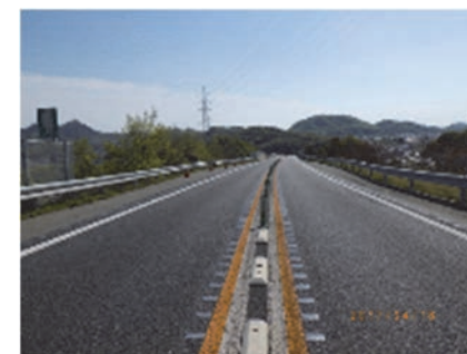
本四高速 西瀬戸自動車道(上下) 尾道出入口~向島IC
