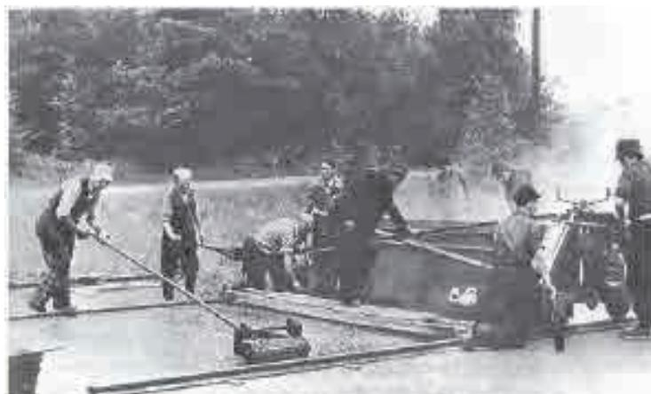
写真4-6： 人力によるアスファルト舗装作業
