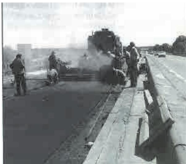
写真 8-5：コンクリートフィニッシャー（稼働中）
