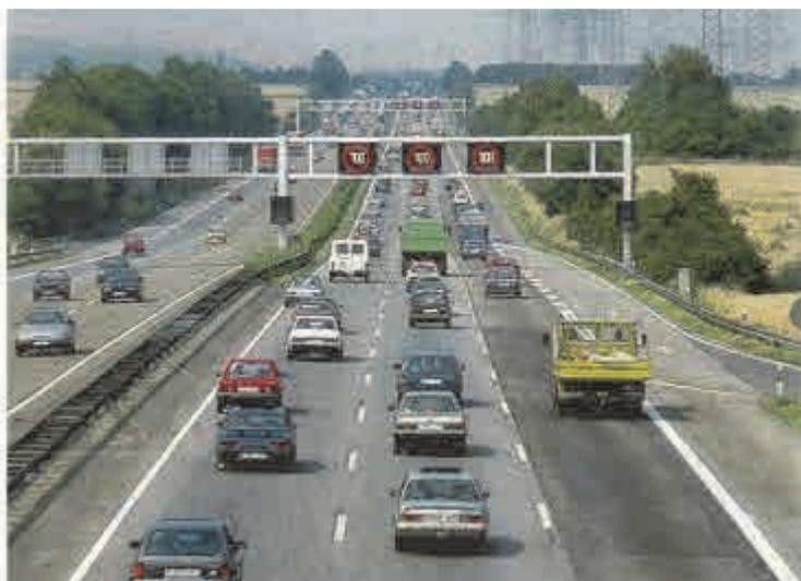
写真 9-10： 可変交通標識(A49号線ミュンヘン北付近)
