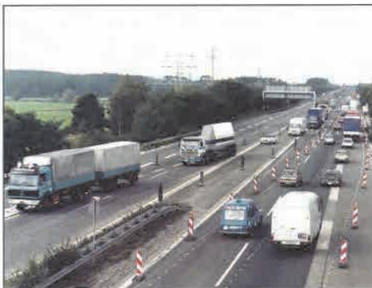
写真5-5 : A3号線とA73号線での『4+1』方式工事
