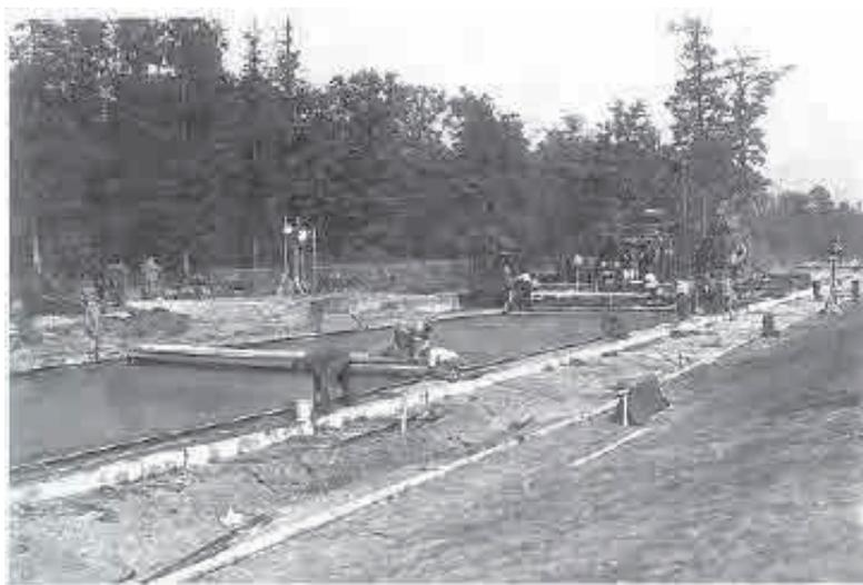
写真 3-6 : A3 号線ケルスターバッハ付近コンクリート舗装
