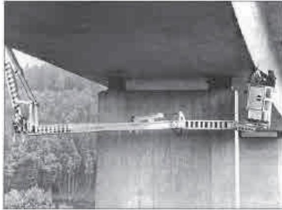
写真 9-7 : 特殊作業車による橋梁点検
