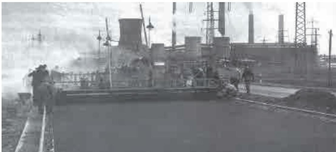
写真 4-7: アスファルト舗装の機械化
