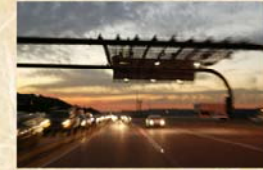
通行料金徴収ゲート (エクスプレス・レーンの 中間、通常の走行速度 で)
