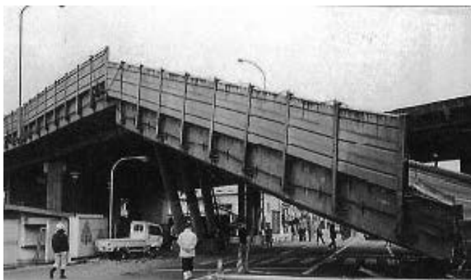
※4 〔阪神・淡路大震災被害状況（名神 瓦木西高架橋）〕
