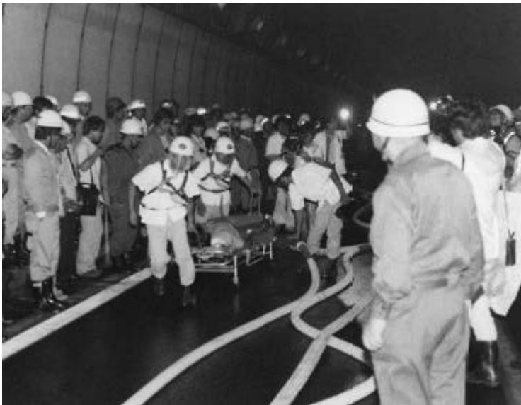
*21 【日本坂トンネルで防災総合訓練を実施 昭和55年6月】
