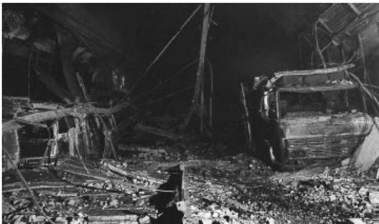
*18 〔日本坂トンネルの車両火災事故 昭和54年〕
