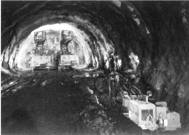
* 9 [ NATM工法が採用された藤白トンネル] (『過去に学ぶ』・(財) 高速道路技術センター・平成2年11月)
