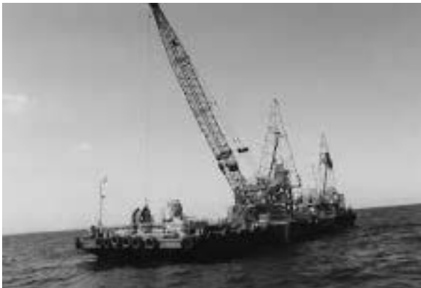
*11 [東京湾横断道路のボーリング調査]
