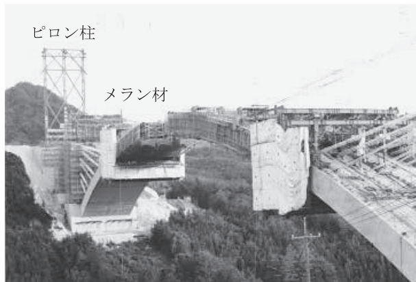
*8 [ピロン・メラン併用工法を採用した中国自動車道 宇佐川橋]
