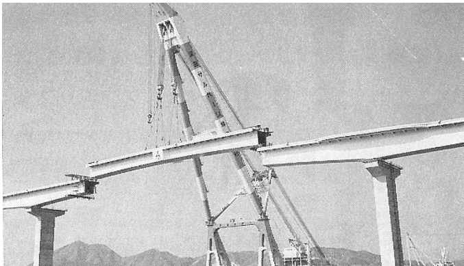
*11 【広島大橋でのクレーン船によるブロック架設】 （『広島建設局20年のあゆみ』・日本道路公団広島建設局・平成元年12月）
