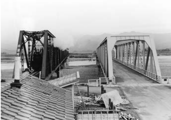
*14 【無料開放道路（越路橋）】
