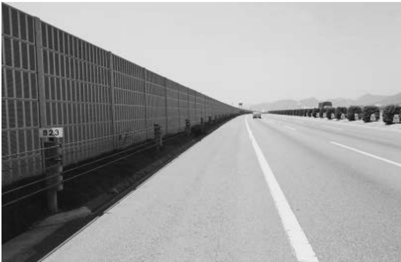
*22 [遮音壁による高速道路の騒音対策]
