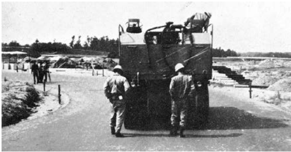
*23 [ブルーフローリングによる締め固め不良個所の確認状況] (『東名高速道路建設誌』・日本道路公団・昭和45年3月25日)
