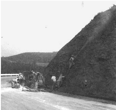
*47 【名神高速道路でのコンクリート吹付工】 （『過去に学ぶ』・（財）高速道路技術センター・平成2年11月）
