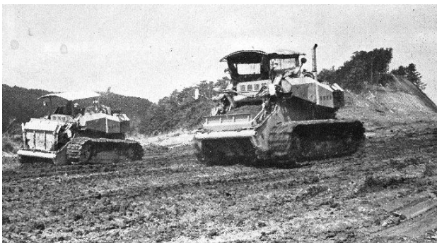
*45 [ローム層での盛土施工に使用されたスクレーパー] (『東名高速道路建設誌』・日本道路公団・昭和45年3月25日)
