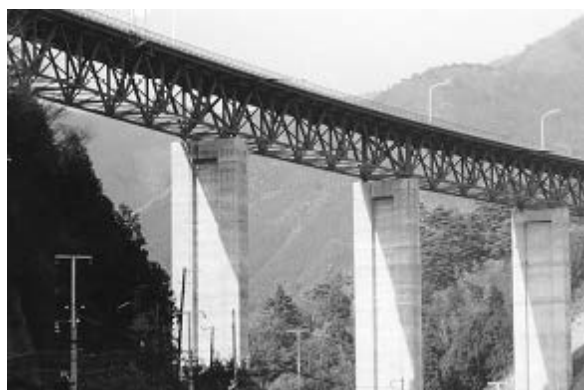
*42 [中央自動車道底沢橋]
