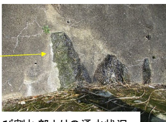
コンクリート吹付けひび割れ部よりの湧水状況
