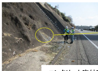
コンクリート吹付けひび割れ部よりの湧水状況
