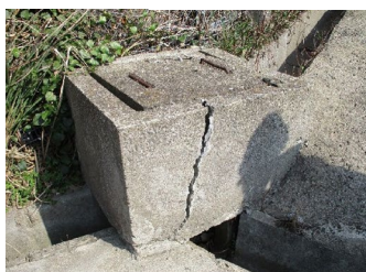
第一小段排水樹、排水溝損傷状況
