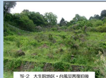
写-2 大生院地区・台風災害復旧後
