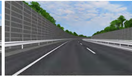
右2 遮音壁+路肩高木
