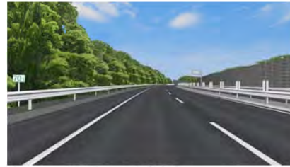
実1 路肩高木+片側音壁
