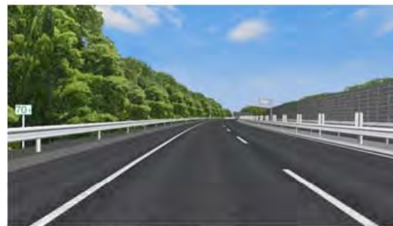
実1 路肩高木+片側音壁
