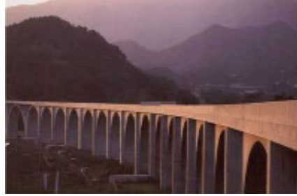
上信越道 上田ローマン橋
