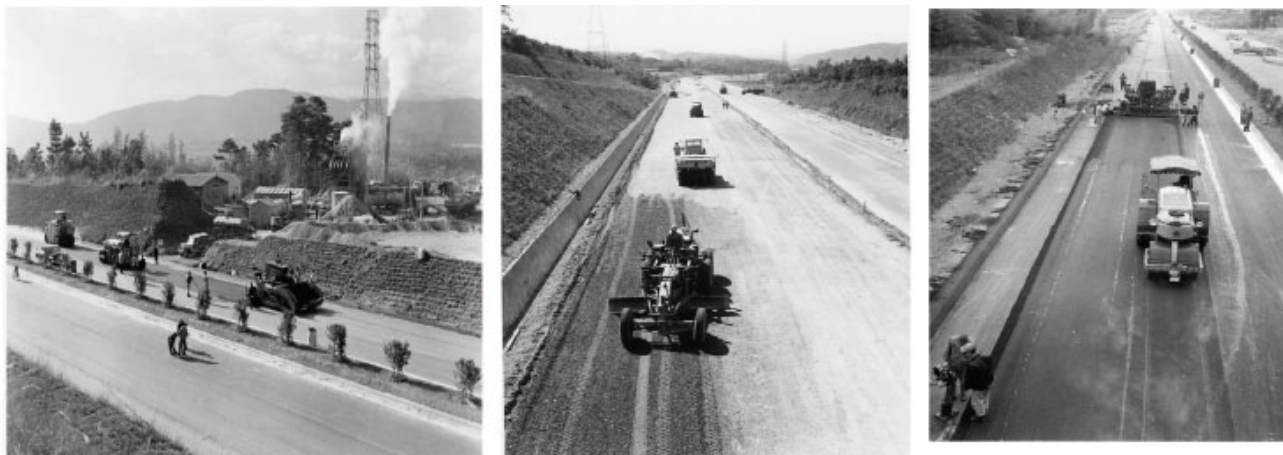
山科試験舗装のアスファルト舗装施工状況
