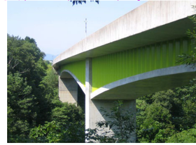
東海北陸道 本谷橋
