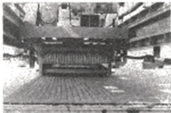
グルービング施工状況
